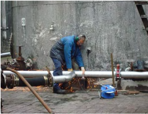
Foto 2: Slijpen in gevarenczone
